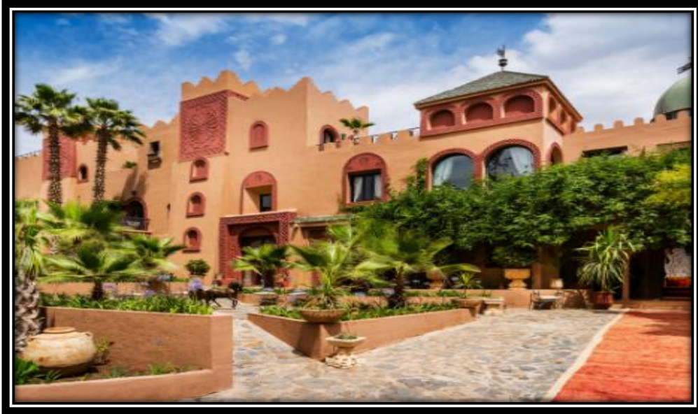
Figure68 : le complexe de kasbah tamadot Source : www.ailes.ch/dataPDF/KasbahTamadot-Maroc-ailes.ch.pdf
