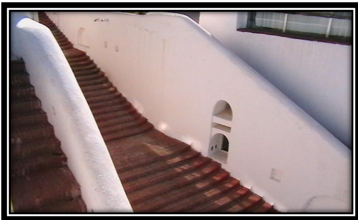
Figure 60: l'escalier Source appareil photo
