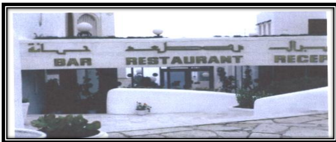
Figure 58:entre d'hôtel Source appareil photo
