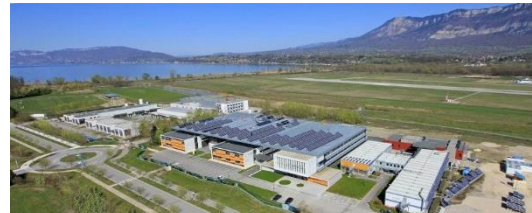
Figure 85 : Installation de l'institut INES (Source : Internet)
