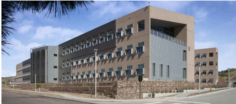
Figure 24 : Façade SUD de RSF siège de NREL (Source : Archdaily.com).
