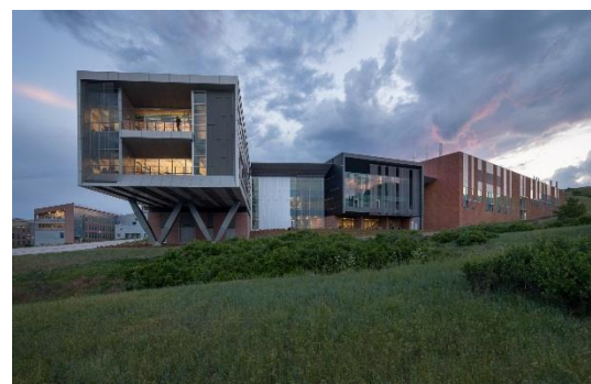
Figure 22 : Laboratoire national des énergies renouvelables (Source : ArchDaily.com)
