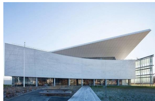
Figure 92: Façade NORD d'INES (Source : Archidaily.com)
