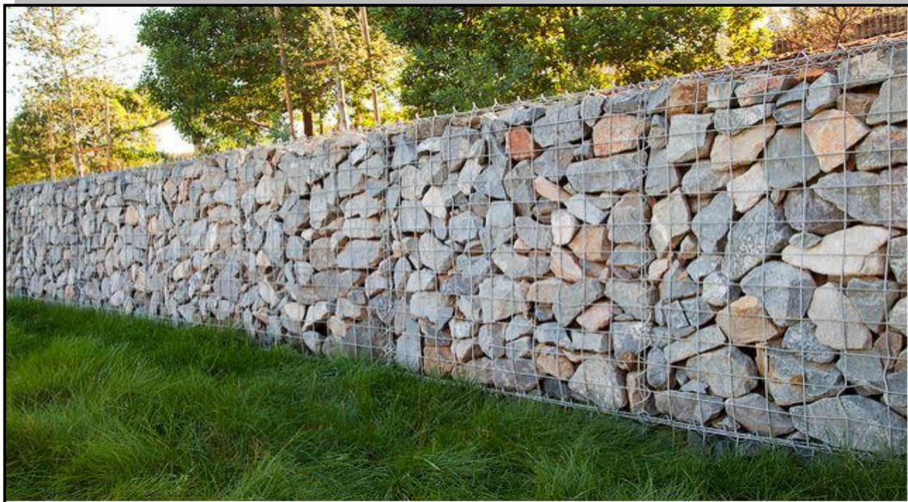
Figure N°122 : Le gabionnage source : www.universalis.fr
