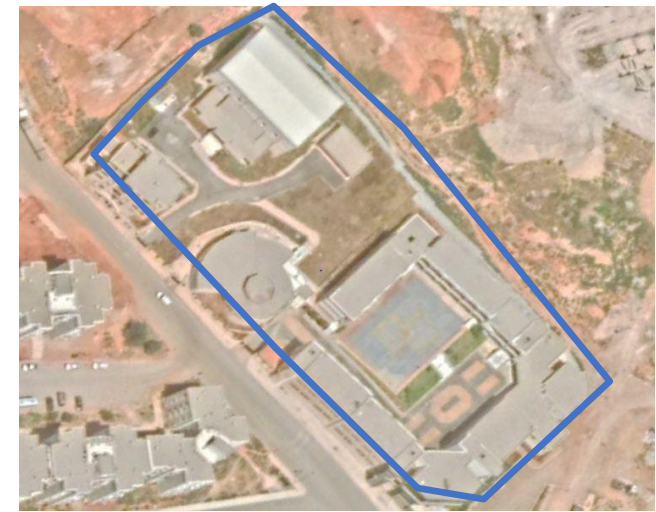
Figure N°94 : Lycée nouvelle ville
