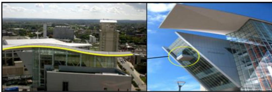
Figure 95: vue du toit en forme de S et du volume ajouté.
