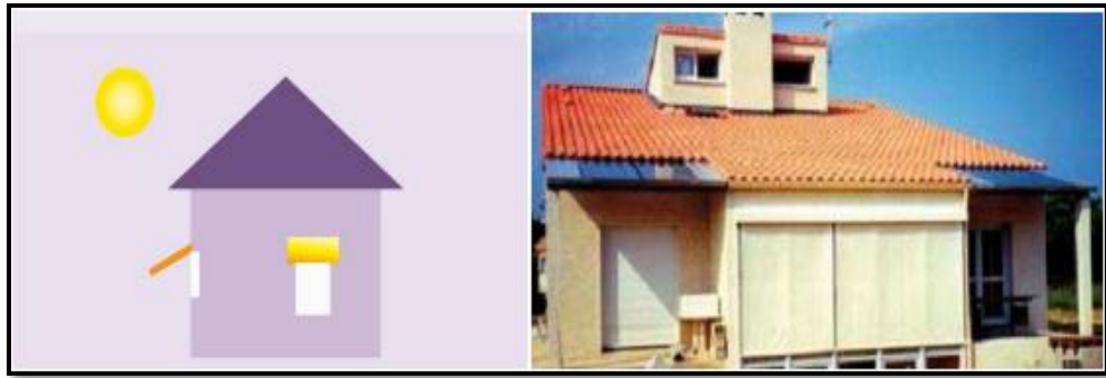
Figure 30: Intégration des capteurs solaires en avant et brise soleil sur les ouvertures.
