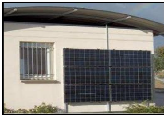
Figure 29: intégration des capteurs solaires sur les allèges.
