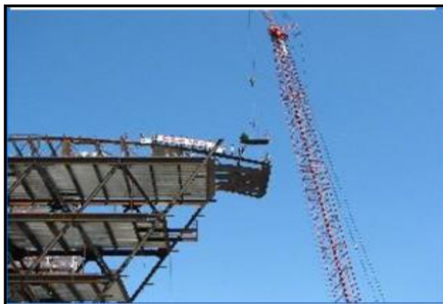
Figure 102: vue du toit en S au cours d'exécution.
