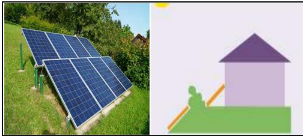
Figure 32: Installation des capteurs solaires sur le sol.
