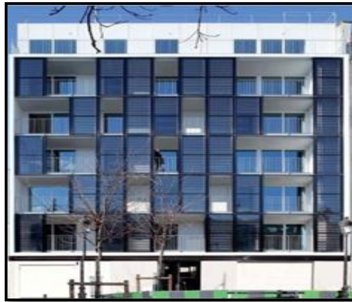
Figure 27: Intégration des capteurs en façade.
