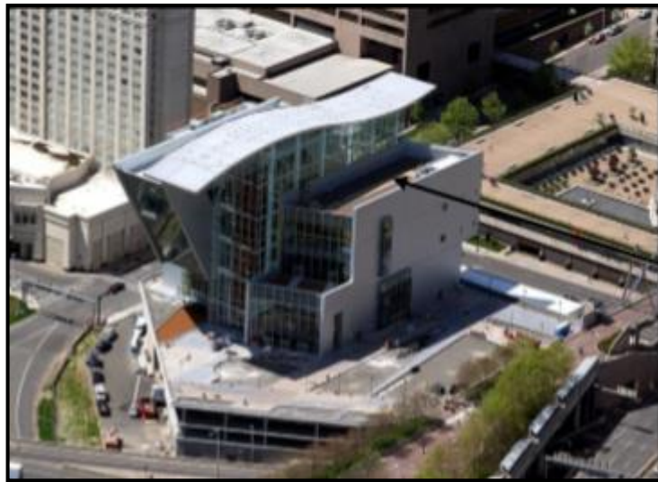
Figure 94: vue du volume du Connecticut Science Center avec le toit jardin.
