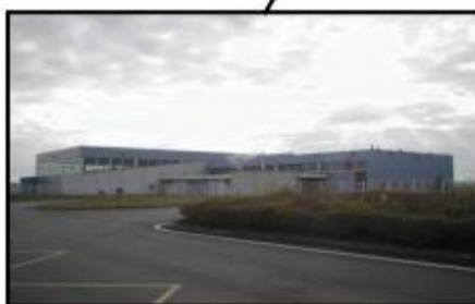
Fig. I 74 : la Salle Gymnase régional
