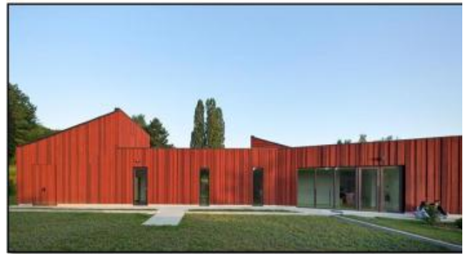
Figure 59 la façade Sud-Est
