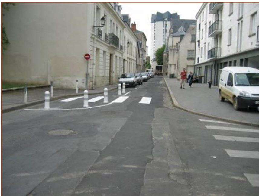
Figure 39 Sécurisation d'une traversée piétonne par la création d'une « oreille » : avancée de trottoir pour améliorer la visibilité des piétons et créer un rétrécissement de la voie (effet de paroi)
