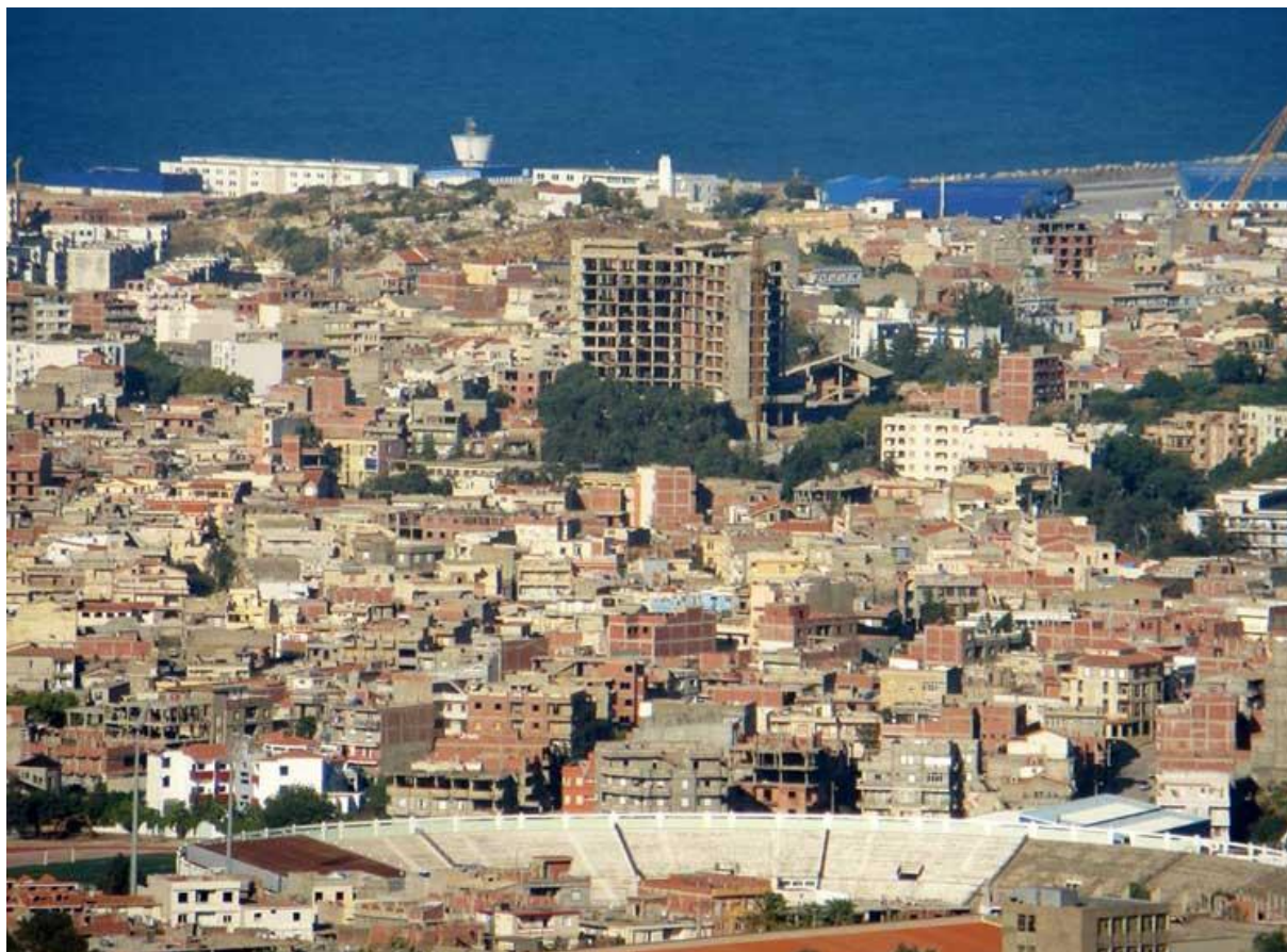
Figure 1 Des milliers de bâtiments non- conformes aux règles
