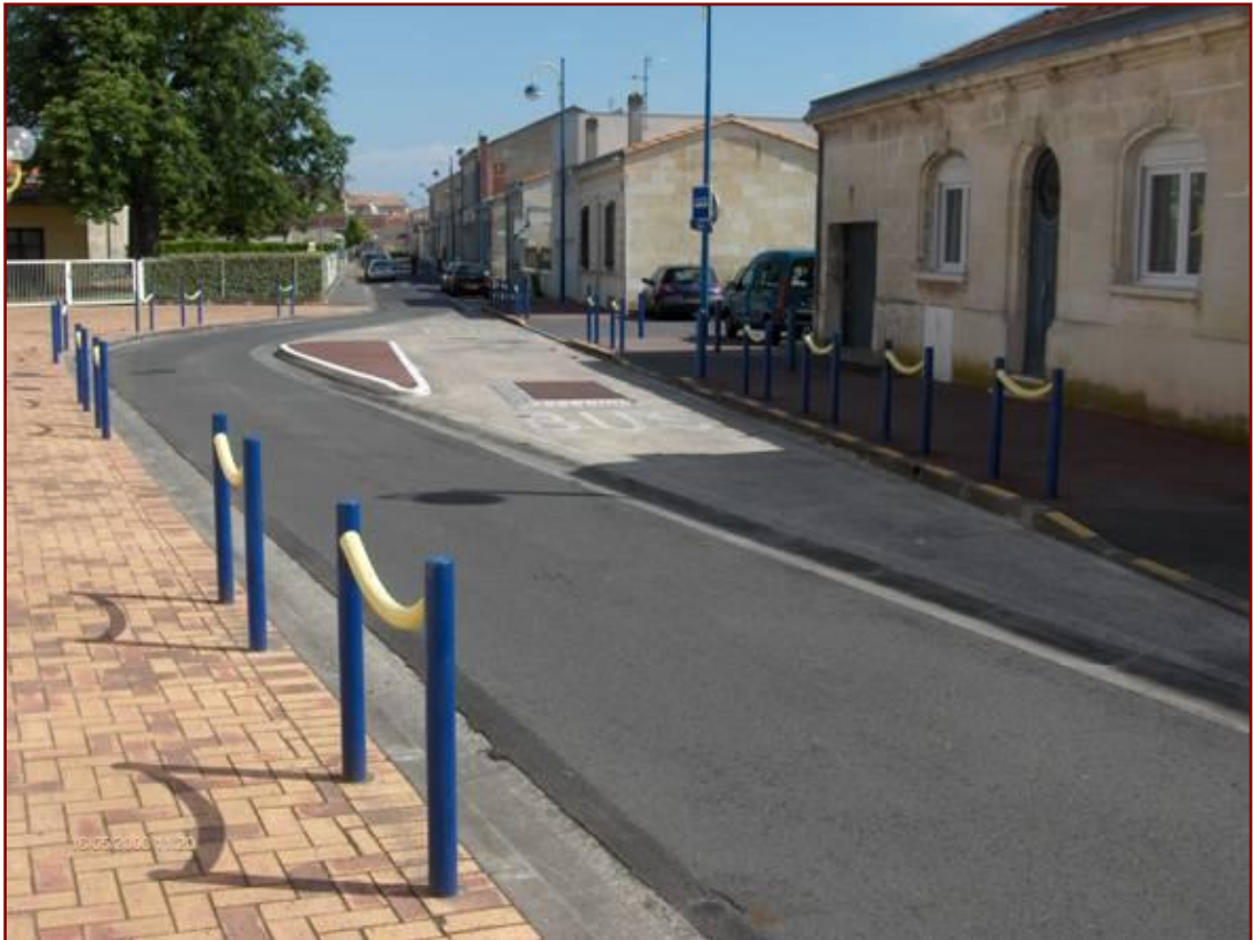
Figure 40 Aménagement pour améliorer et sécuriser l'accès au bus
