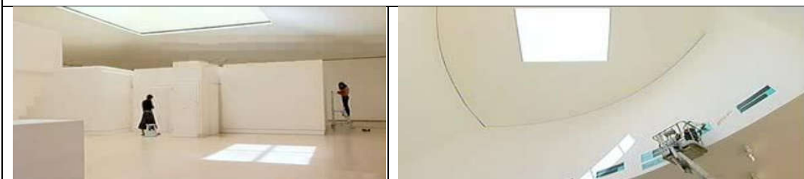
Figure -190- : L'éclairage zénithal dans le musée de GUGGENHEIM.
