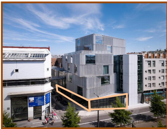
Figure 81: vue perspective de l'ENSAS Strasbourg. Source: ( https://www.amc-archi.com ).
