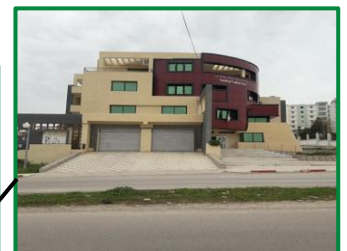
Figure 119 : Inspection des travaux. Source : (auteur).
