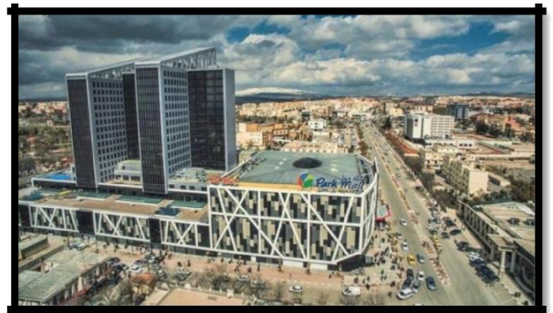
: La façade du Park mall
