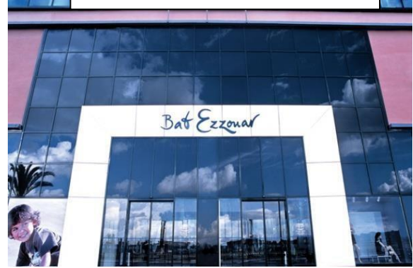
Figure : l'entrée de centre commercial
