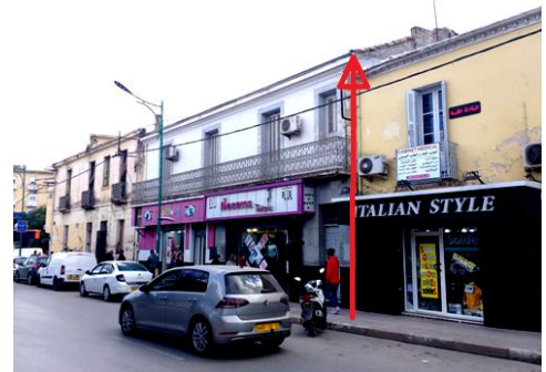
Figure 39:immeuble de boulevard Guelma
