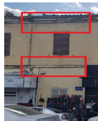
Figure 37: corniche et bandeaux du corpus
