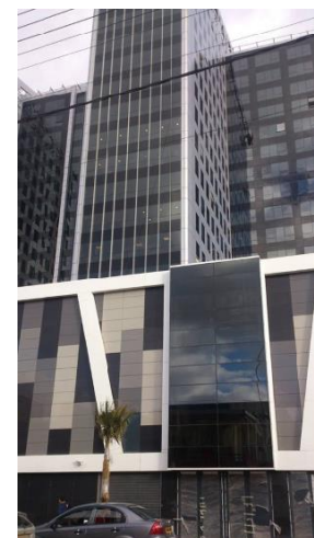
Figure 141 : Façade du projet Source : Site internet
