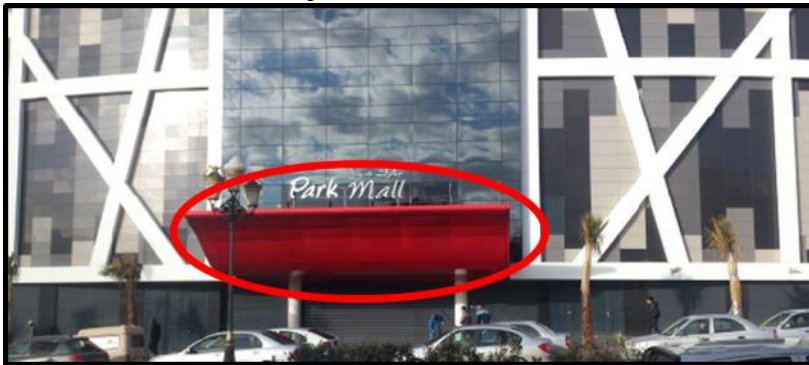
Figure 140 : Façade du projet Source : Site internet
