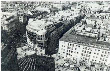
Figure 77 : Le centre commercial HAAS HAUS Source : Site internet
