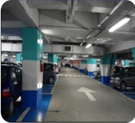
Figure 88 : Le parking Source : L'auteur
