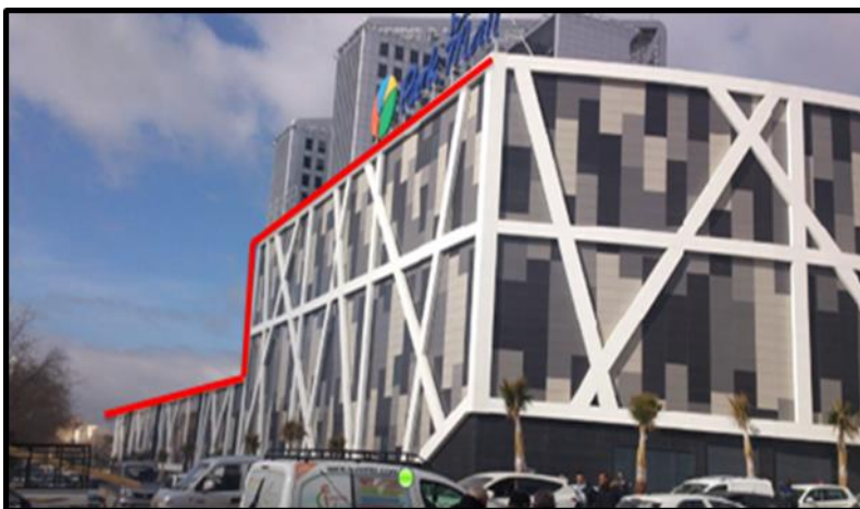
Figure 142 : Façade du projet Source : Site internet
