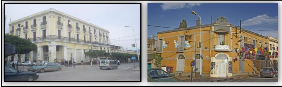
Figure 71:immeuble coloniaux du centre-ville
