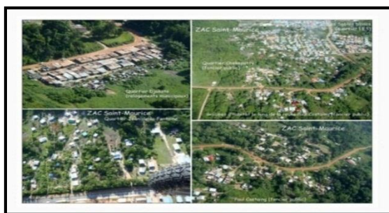
Figure 8: habitat spontané : logements en partie dégradés-dalles en attente d'extension tôles ondulées à reposer en cas de fortes pluies, etc.
