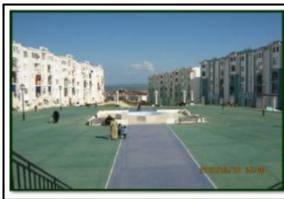
Figure 84: la cité frères REHABI
