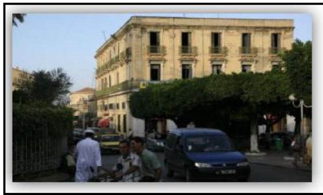
Figure 72: l'état des constructions de l'époque coloniale.
