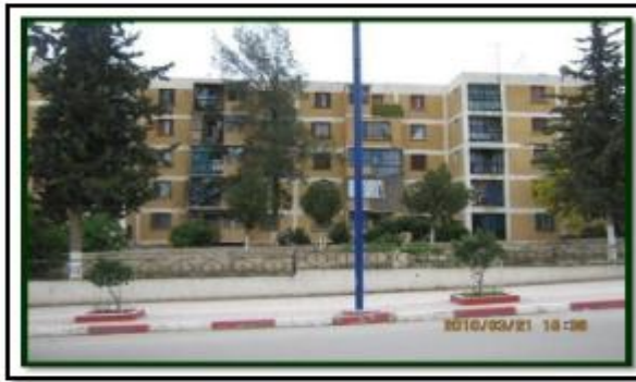
Figure 88: la cité frères REHABI
