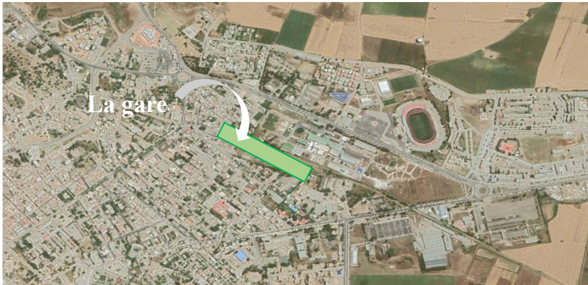
Figure N-°53 :la gare ferroviaire de Guelma. Source : Google earth +traitement personnel.
