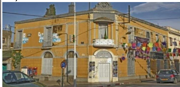
Figure n°40 : équipement de l'époque coloniale
