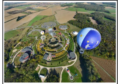
Figure 76: Photo aérienne du projet
