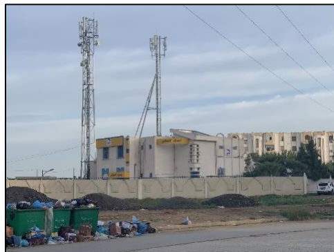
Figure IV-61: la poste, source : auteur.
