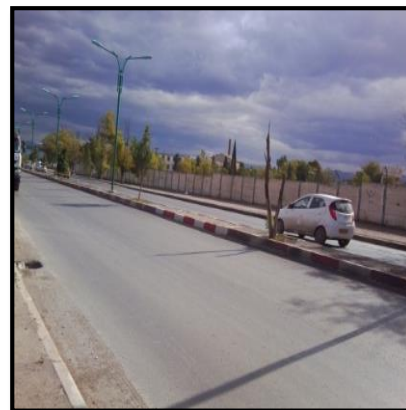
Figure IV-38: la route nationale N20, source : auteur
