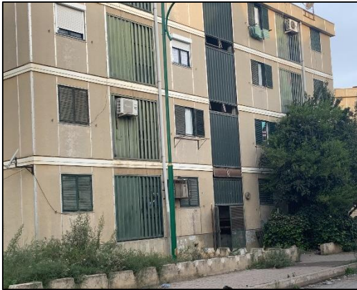
Figure IV-70: habitat collectif en préfabriqué legé, source : auteur.
