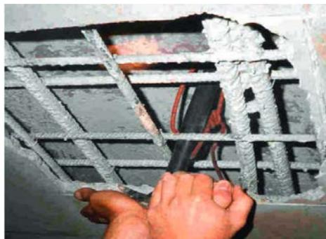
**Figure IV.23.** Une zone creuse en béton coffré armé [12]
