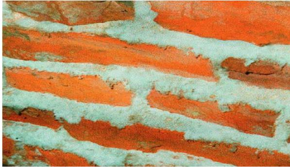
**Figure IV.3.** Efflorescences sur mortiers anciens à base de chaux [12]
