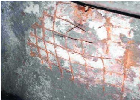
a) Enrobage insuffisant du treillis soudé (malfaçon)
