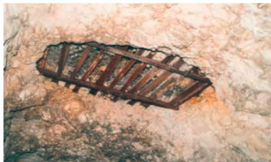
**Figure IV.6.** Karst rempli de matériaux mal consolidés et protection contre les chutes de matériaux par profilés métalliques [12]
