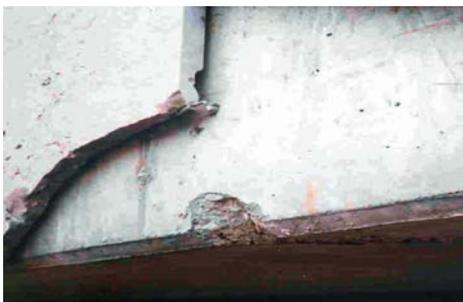
a) Rupture d'un parement due à un choc de poids-lourd
