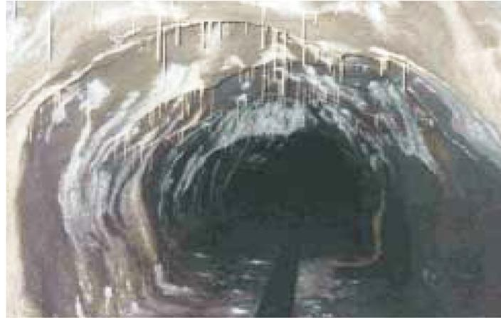
**Figure VI.1.** *Stalactites et coulures de calcite blanche sur du béton projeté (dissolution de la chaux du ciment par percolation des eaux du terrain) [12]*
