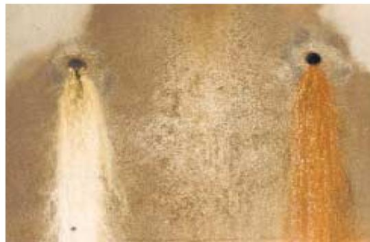
**Figure VI.2.** *Concrétions claires de calcite [12]*
