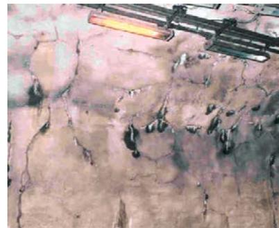
b) Faïençage d'un béton projeté sur rocher
