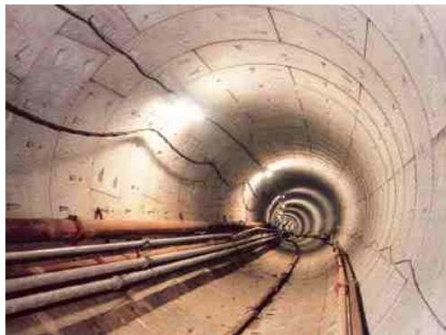
**Figure II.36.** Voussoirs en béton [16]
