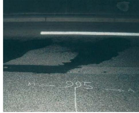
b) Remontée d'eau au travers du béton bitumineux (Bombements, affaissements localisés).
