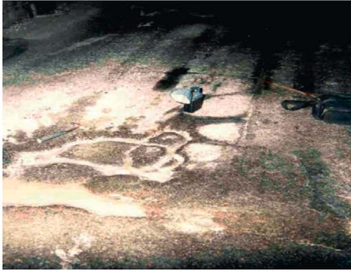
a) Faïençage et flaches avec remontées d'eau (Fissures longitudinales ou transversales,
