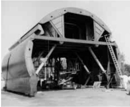
**Figure II.34.** Coffrage de tunnel [16]
