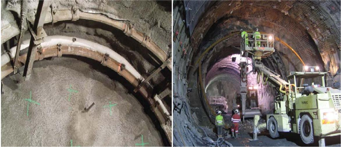
**Figure II.27.** Cintres TH, boulons radiaux et béton projeté. Détail de la voûte d'une galerie du laboratoire souterrain de l'Andra [16]
