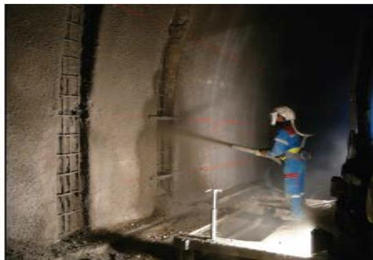
**Figure IV.28.** Renforcement des tunnels par raidisseurs
