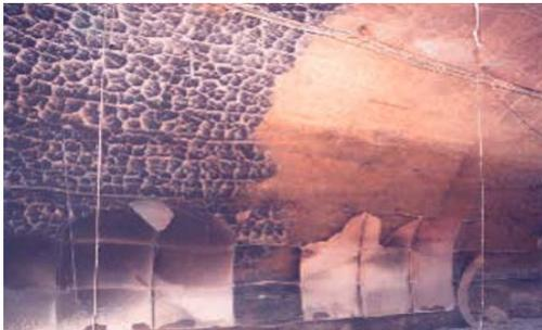
a) Béton faïencé [limite thermique nette marquée par le dépôt ou non de la suie sur le faïençage],
