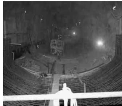
**Figure II.35.** Armatures de radier
