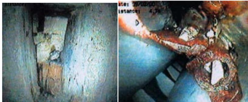
**Figure IV.17.** Désordres des drains et caniveaux d'intrados
