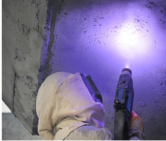
**Figure IV.30.** Protection des aciers par un procédé électrochimique
