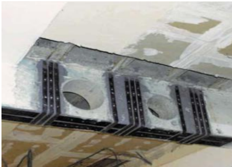
Figure II.16 Renforcement d'une poutre au moyen de matériaux composites.
