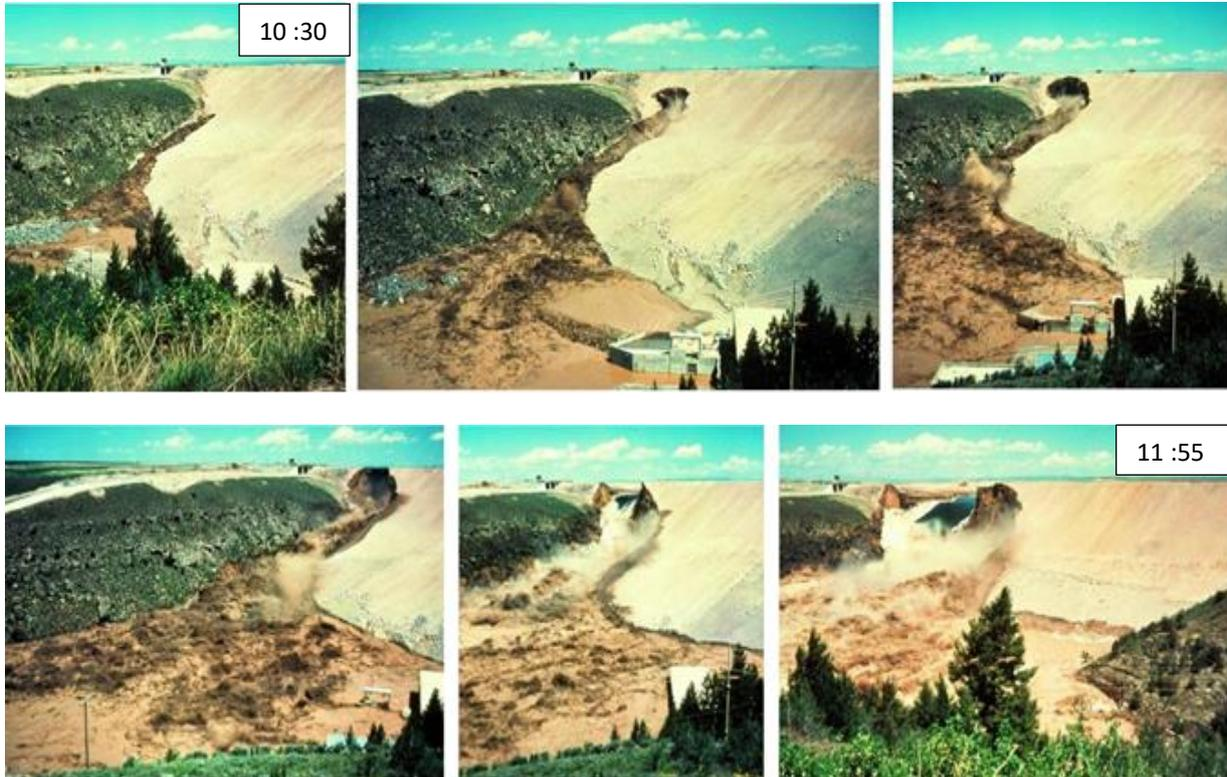
Figure III.2 Etapes de la rupture du barrage « Teton dam » : des premiers signes d'érosion visibles près du socle rocheux, jusqu'à la rupture et l'inondation, via l'apparition de l'écoulement boueux et l'élargissement de la brèche [8]
