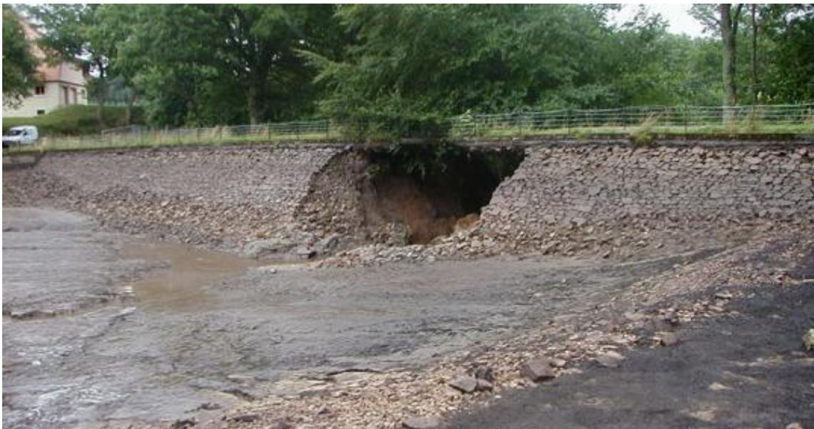
Figure III.8 le phénomène de renard dans une conduite à cause de faiblesse de réalisation (défaut de compactage) [8]
