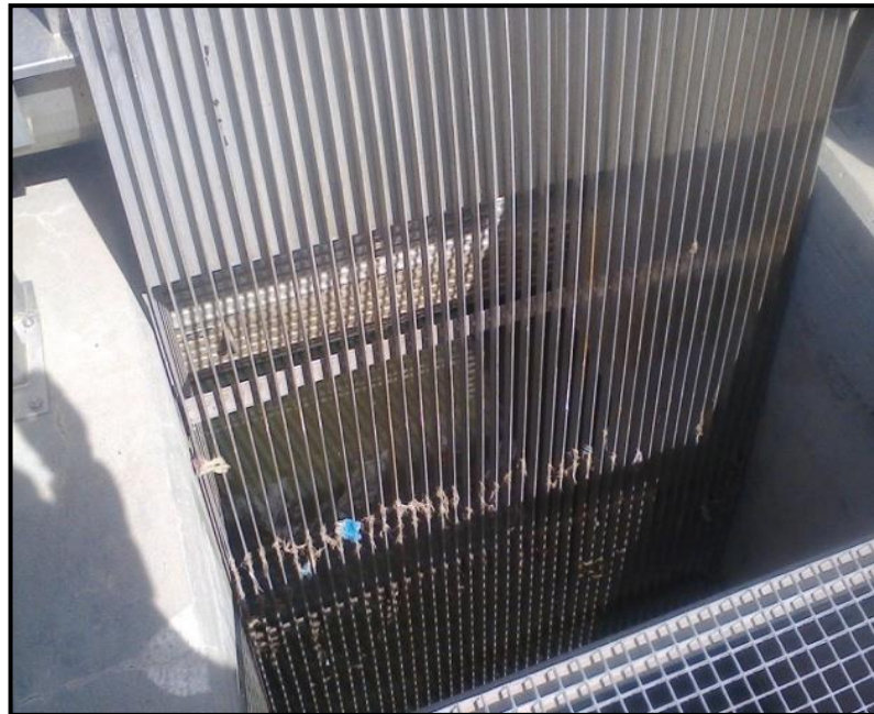
Figure I-5 : dégrilleurs.
