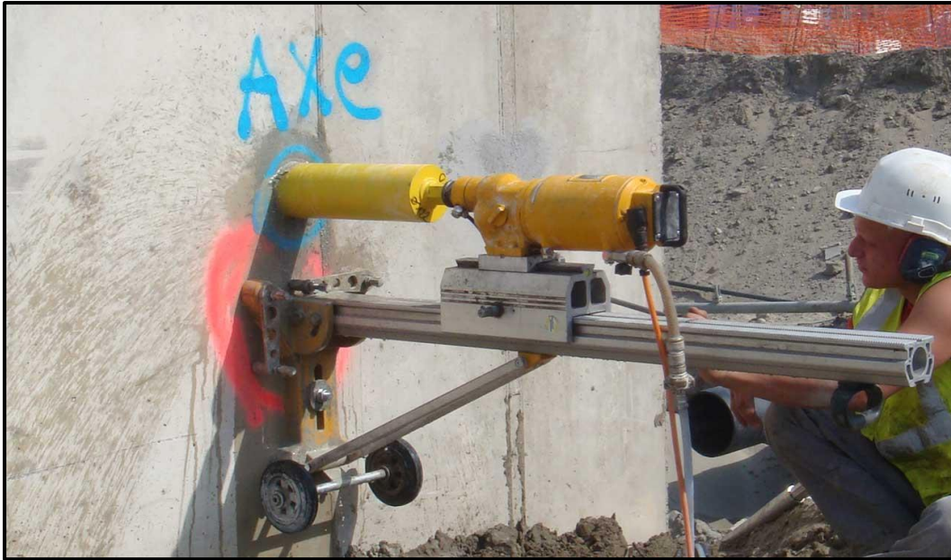
Figure III-4 : Carottage.
