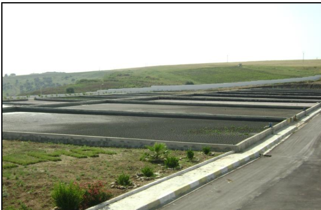
Figure I-23 : Lits de séchage.
