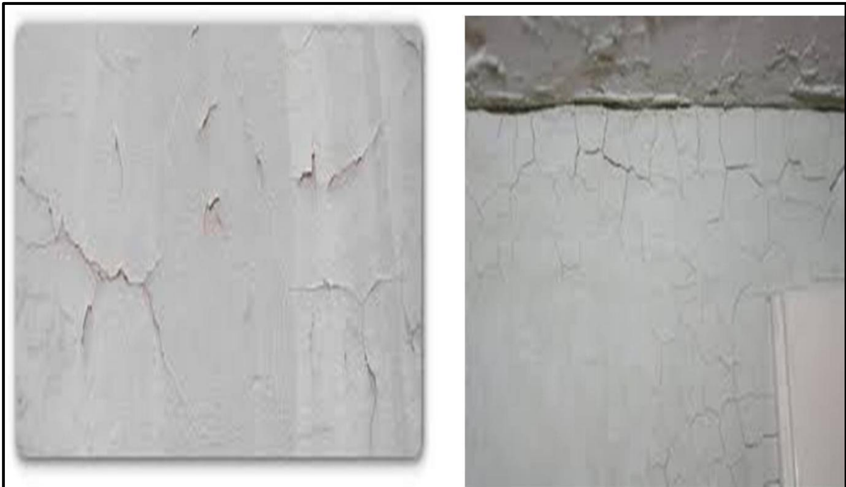
Figure II-18 : phénomène de faièncage.
