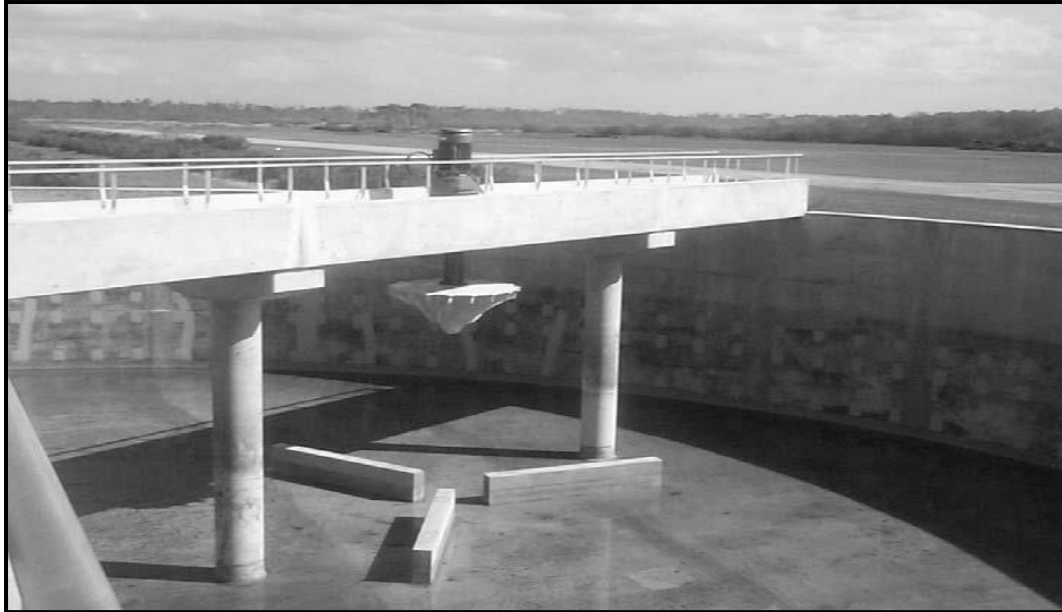
Figure I-12 : Bassin aéré mécaniquement par des turbines de surfaces.
