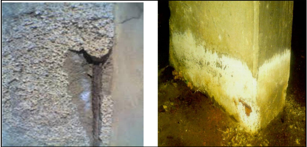
Figure II-3 : attaques sulfatiques.
