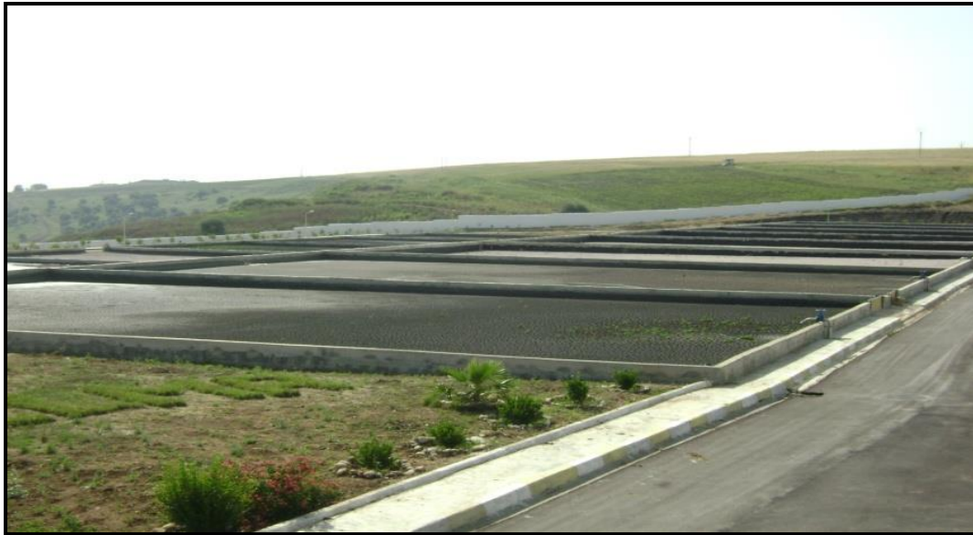
Figure I-14 : Lits de séchage.
