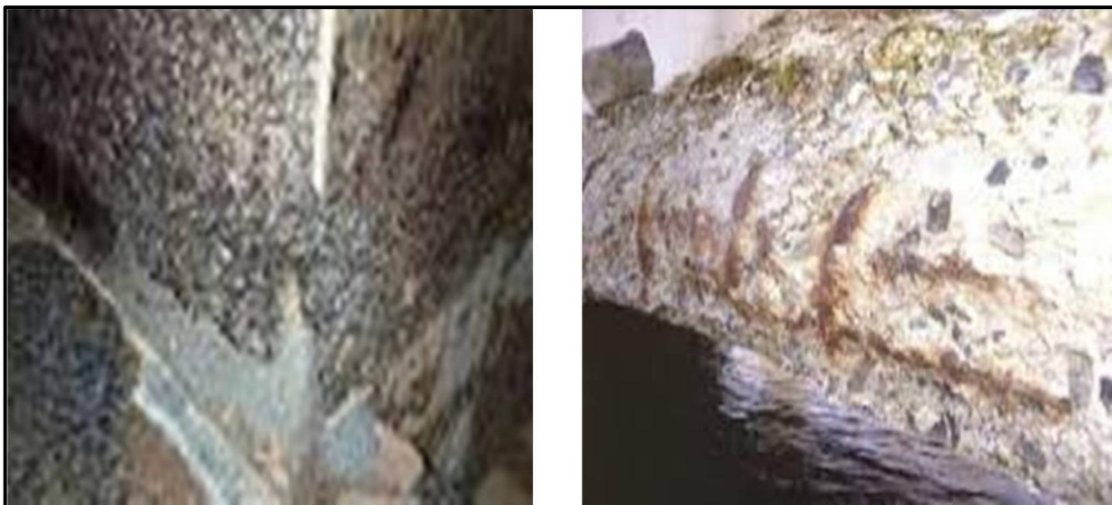
Figure II-4 : Attaques acides.
