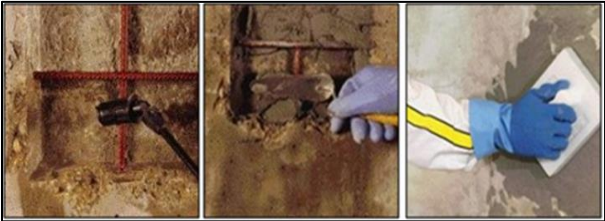
Figure IV-2 : Gauche à droite ; Aciers dégagés, Application du mortier, Finissage par taloche.
