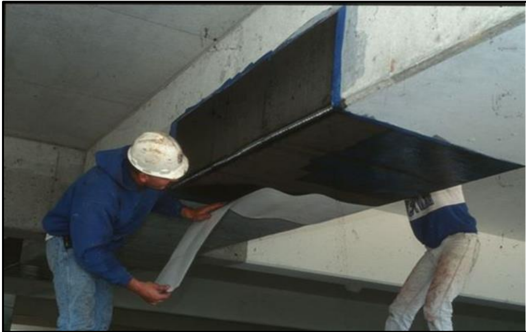
Figure IV-5 : Feuille de polymère renforcé de fibre de carbone.
