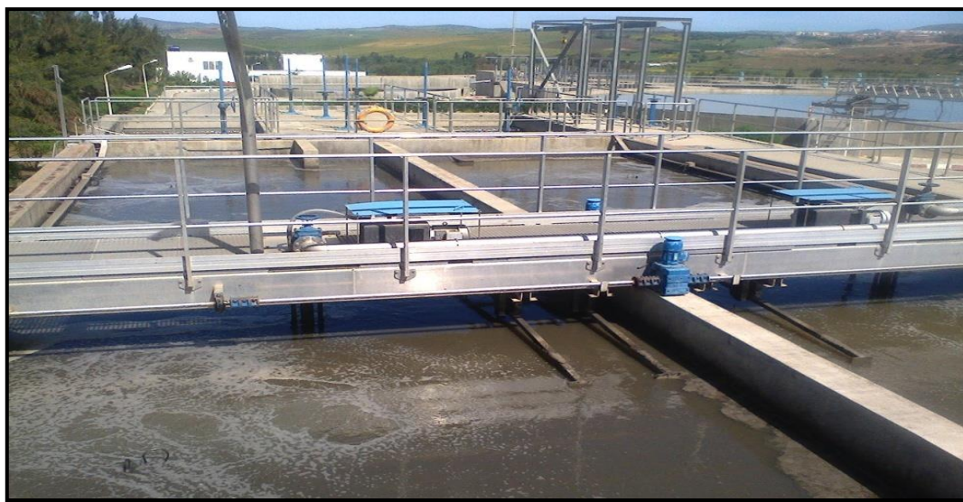
Figure I-6 : Dessablage – Déshuilage.
