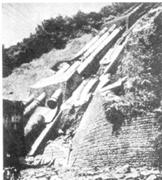
Figure (1.1) : Vue d'une conduite forcée éclatée de la centrale électrique d'Oigawa, du Japon [9]
