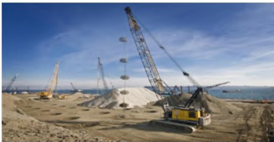
Figure 3.3. Chantier d'un compactage dynamique profond.
