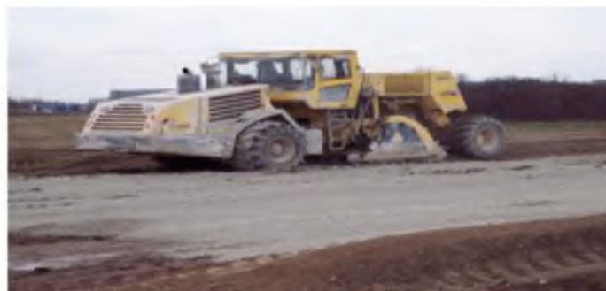
Figure 3.9. Chantier de traitement du sol au ciment.
