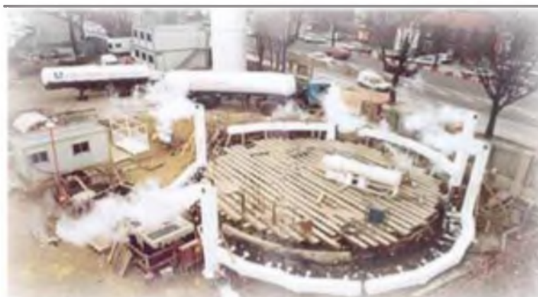
Figure 3.7. Chantier utilisant la congélation du sol.
