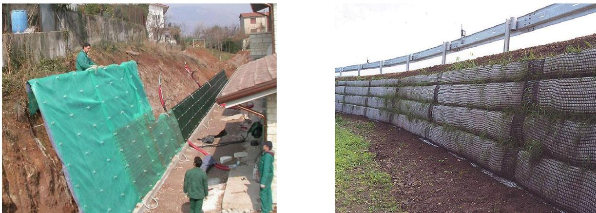
Figure I.17. Exemple de géogrille.
