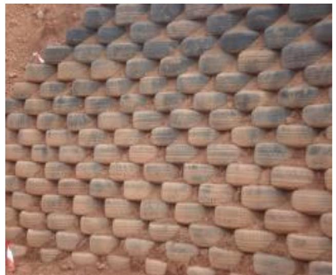
**Figure I.15.** Mur en pneu sol
