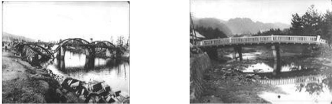
**Figure II.9.** Le séisme de Kanto (Japon) de 1923. Grands tassements et rotations au niveau de la fondation de piles de ponts.
