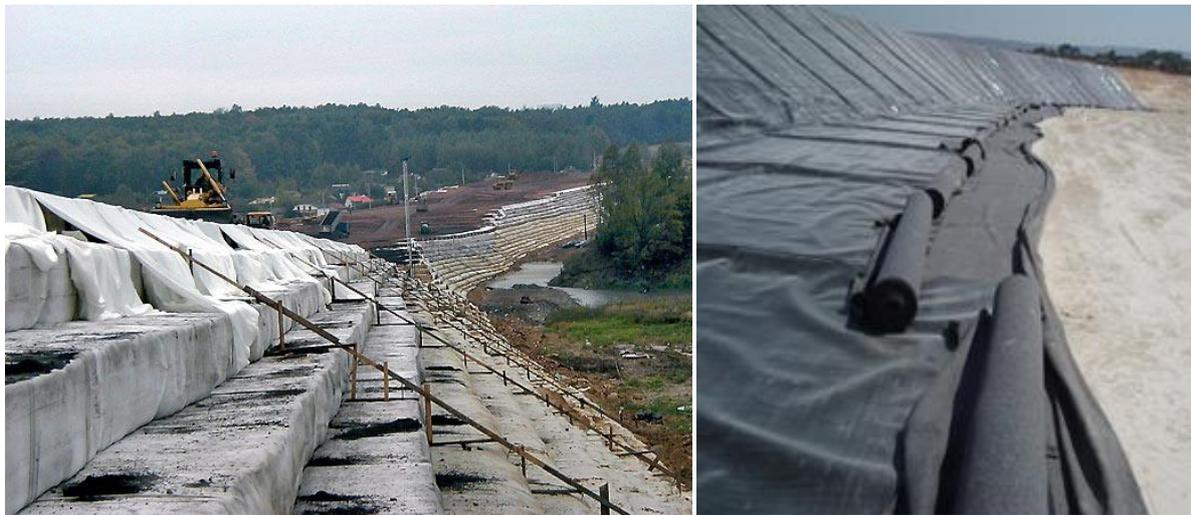
Figure I.16. Exemple de géotextile.
