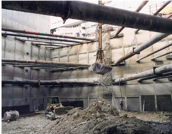
**Figure I.8.** Renforcement par butons.
