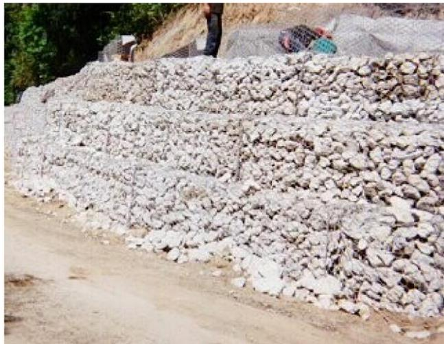
Figure I.3. Mur en gabion.
