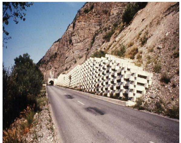
Figure I.4. Mur en éléments préfabriqués en béton empilés.
