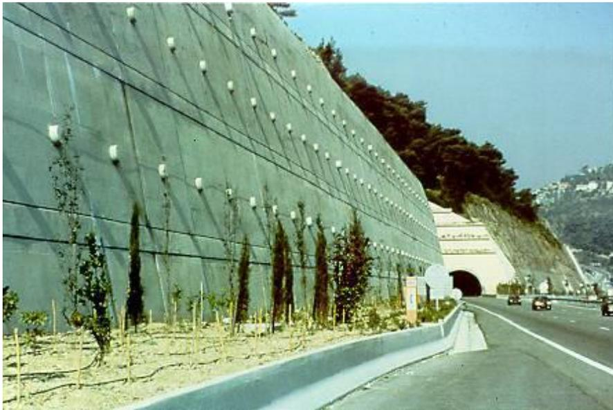
**Figure I.11.** Exemple de mur cloué.
