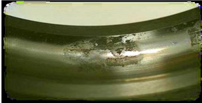
Figure 1.3. Déficit de roulement. Corrosion
