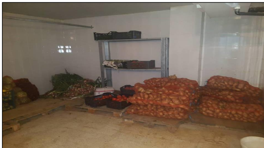
Figure 8 : Murs de chambre froide revêtus de carreaux lisses (Photo personnelle).
