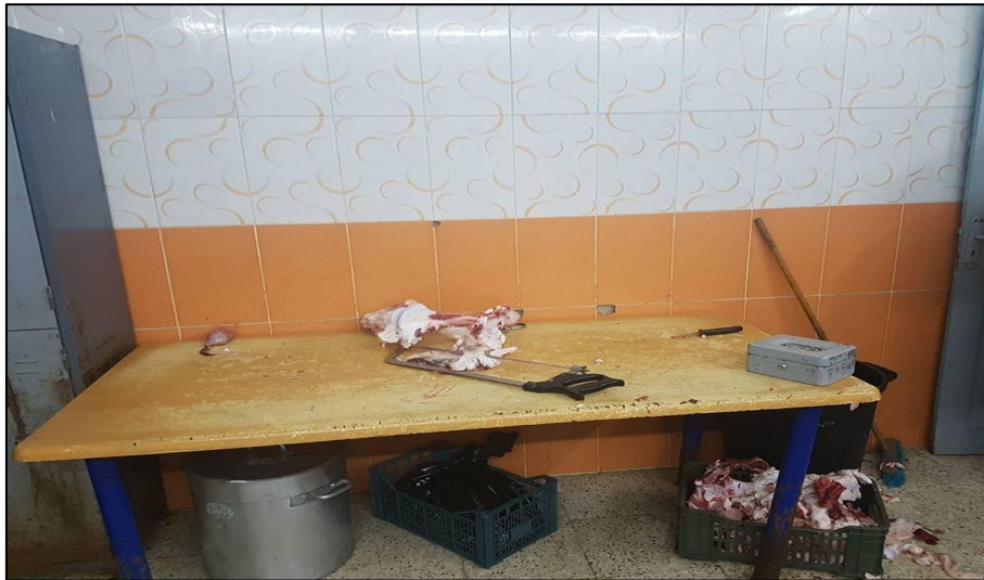
Figure 4 : Mur de boucherie revêtu de carreaux lisses à 2 mètres de hauteur (photo personnelle).
