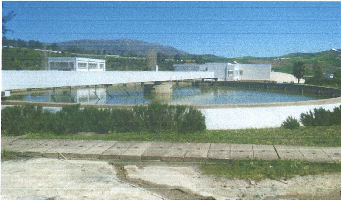
Figure 08 : l'étape de décantation de l'eau brute.
