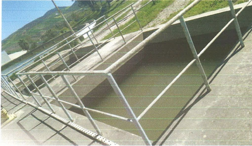
Figure 05 : l'étape de pré-oxydation de l'eau brute.
