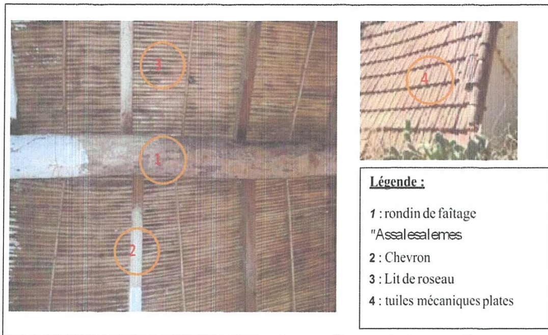
Figure 35: Composition de la toiture (S.Salmi.Ait Itchir, nov 2010)
