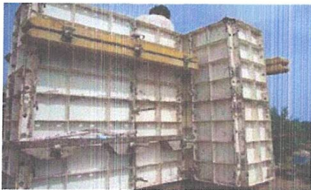
Figure 11: Coffrage métallique du pisé moderne Photo: N.Munier
