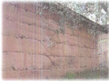
Figure 34: Mur en pisé sans enduit (S.Salmi.Ait Itchir, nov2010)
