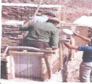
Figure 10: Mis en œuvre d'un pisé traditionnel à l'aide d'un coffrage en bois, Source : technique de pisé 1997
