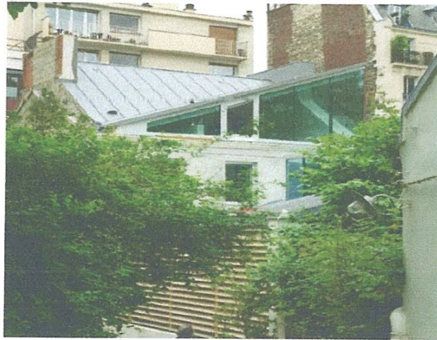
Photo 4: maison A (source : Réussir son installation domotique et multimédia (François-Xavier Jeuland))
