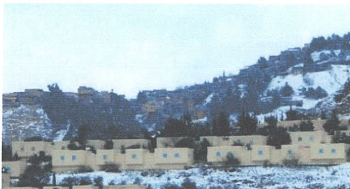
Photo 06 : La façade des bungalows de complexe de Guergour
