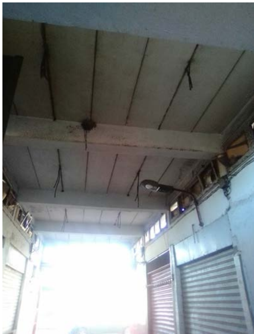
Figure V.2: Dalles en béton cellulaire ceinturées par des poutres en béton armé
