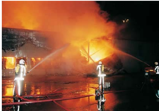
Figure II.24 : Exemple d'incendie dans un bâtiment de stockage, compartimenté par des murs coupe-feu en béton cellulaire.
