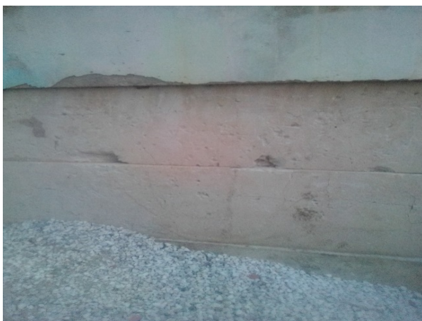
Figure V.5: mur en beton cellulaire
