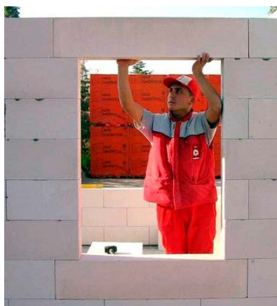
Figure III.3: Linteau en béton cellulaire
