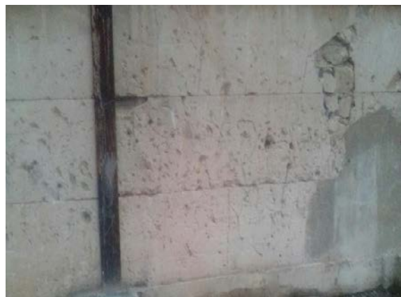
Figure V.10: Autre photo du mur en béton cellulaire
