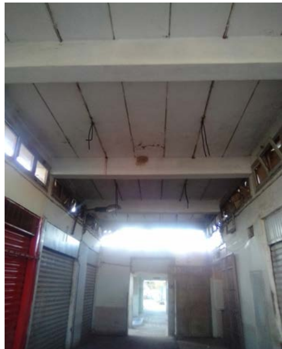
Figure V.2: Dalles en béton cellulaire ceinturées par des poutres en béton armé
