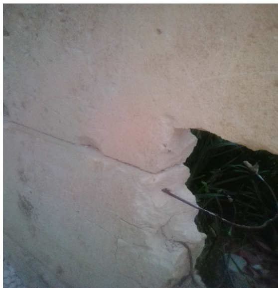
Figure V.11: Béton cellulaire armé
