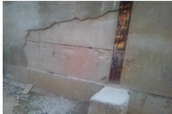
Figure V.8: Enduits de mur
