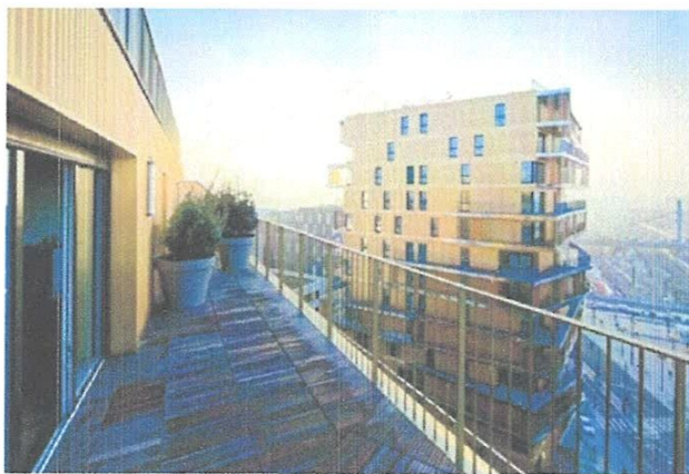
FIG 14-15 : Façade de l'immeuble d'habitation. Source : Google.
