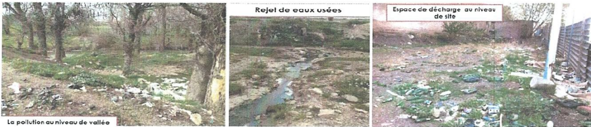
Fig.55 : L'état dégradé de la vallée de Boussellem
