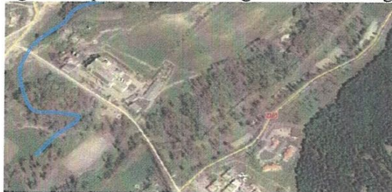
Fig. 58: La présence d'usine Fig.
