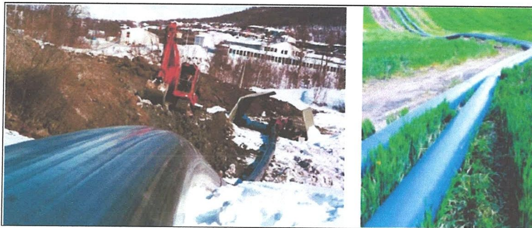
Figure.9 Flexibilité des tubes en PEHD. [10]
