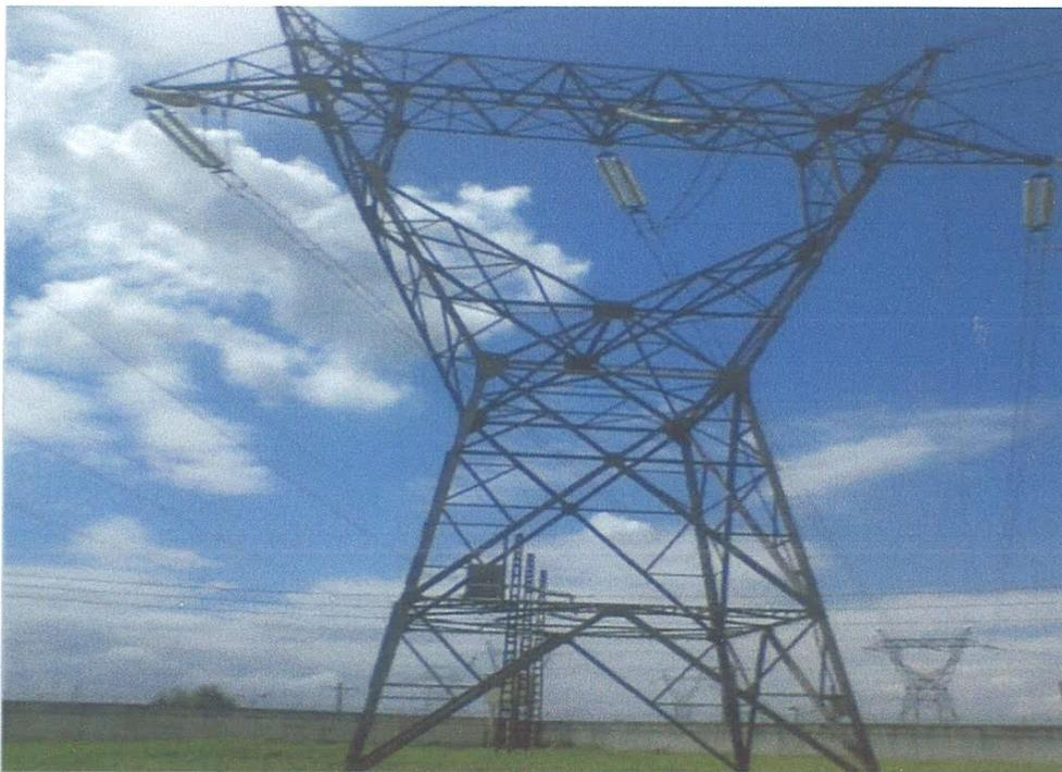
**Figure VII 1 : modèle étudié Ligne simple en Nappe Horizontal de 220 KV**
