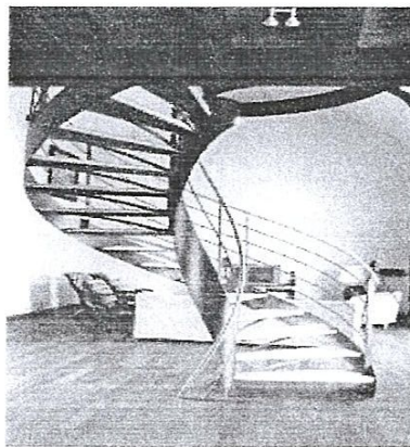
Figure 5: utilisation d'acier dans la construction
