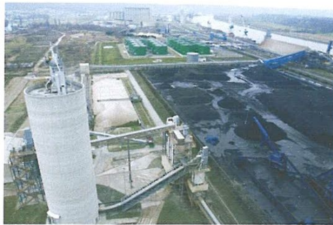
Figure 10 : Photo d'équipements installés sur le silo
