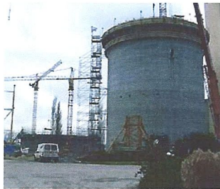
Figure 48 : Avancement des travaux
