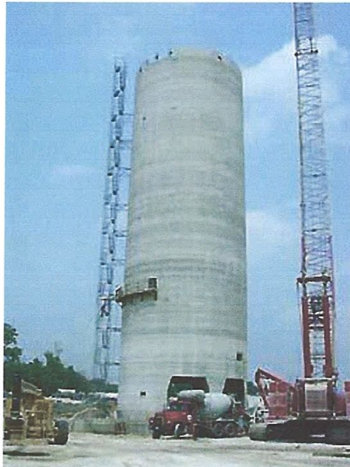
Figure 49 : Fin d'exécution du fût cylindrique
