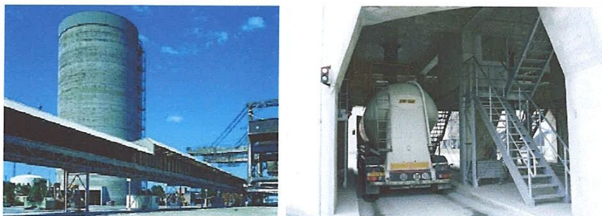
Figure 26 : Photos d'un silo de stockage de ciment
