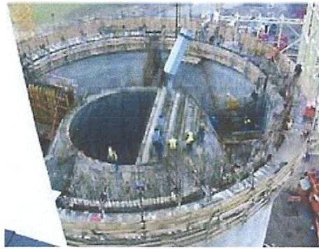
Figure 47 : Exécution de la dalle inclinée et du cône inversé
