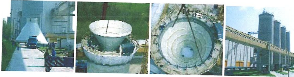
Figure 13 : Photos de réalisation de silos traditionnels
