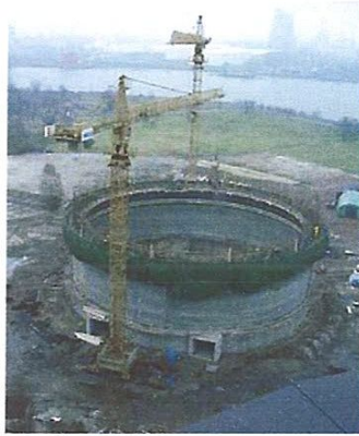
Figure 46 : Exécution du fût cylindrique par un coffrage glissant
