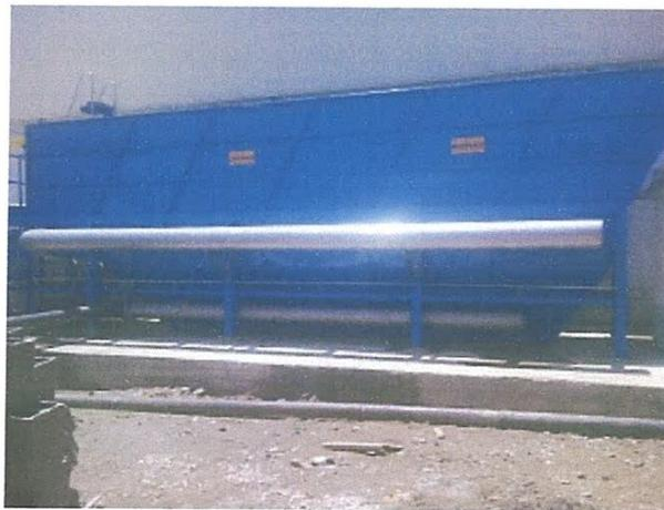
**Figure II-2 : Décanteur**
