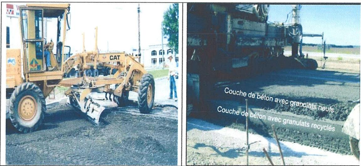
**Photo. V.1:** l'utilisation des agrégats recyclés dans des bétons routiers.
