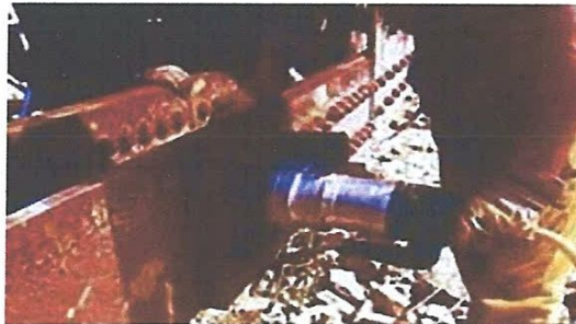
Fig. 1.3 : Serrage contrôlé de boulons précontraints avec une clé dynamométrique
