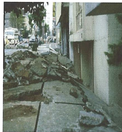
Figure 2.15 : Endommagements des structures au niveau de la fondation après le séisme de Guerrero- Michoacán (Mexique, 1985)
