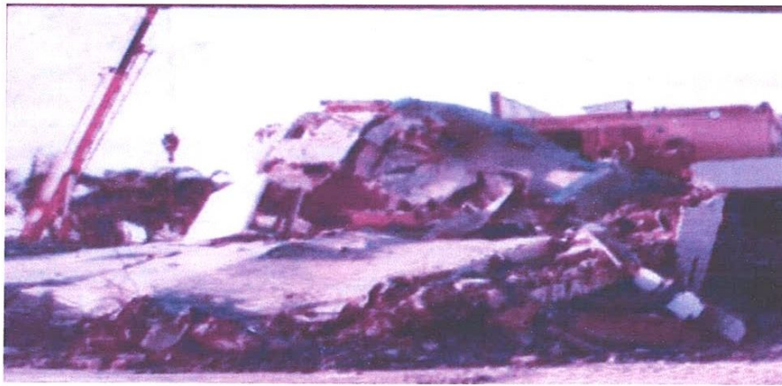
Figure 1.14 : Exemple d'effondrements d'immeubles lors du séisme du 10/10/80
