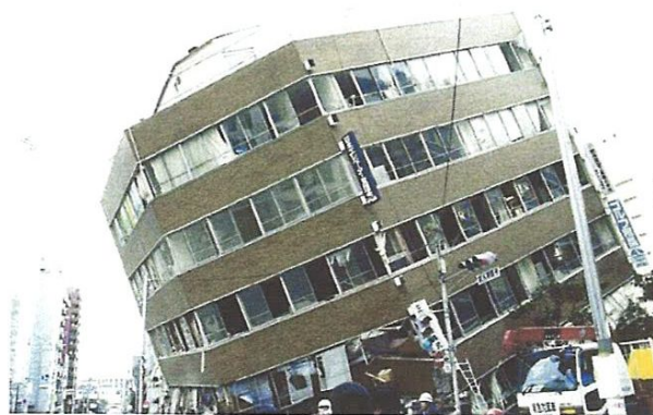
Figure 2.14 : Contreventement excentré (pignon) au RdC et effondrement par excès de déplacements ; structure en béton armé
