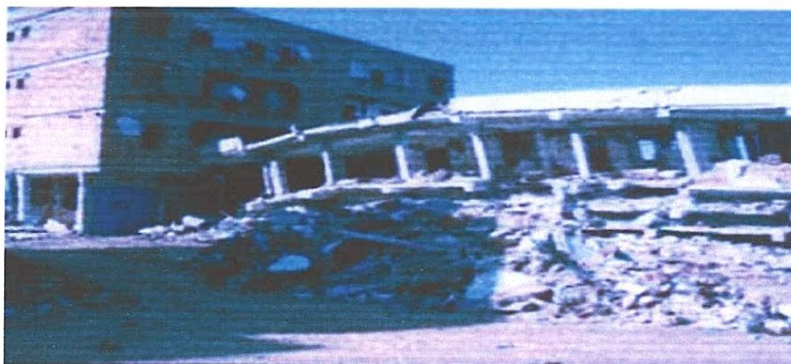
Figure 1.16 : Ampleur des dégâts du séisme de Boumerdes
