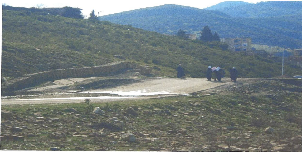
Photo 4.2 Vue générale du point de glissement de Bouhamdane
