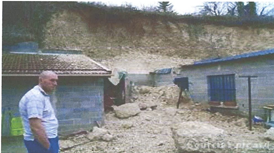
Photo 1.1 Le phénomène d'effondrements
