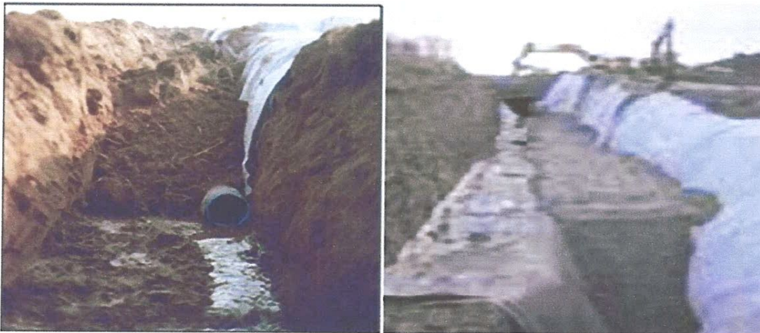
Photo 4.7 La phase de réalisation de tranche drainante
