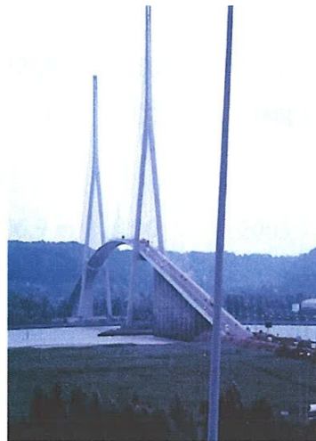
Pont de Normandie (France)
