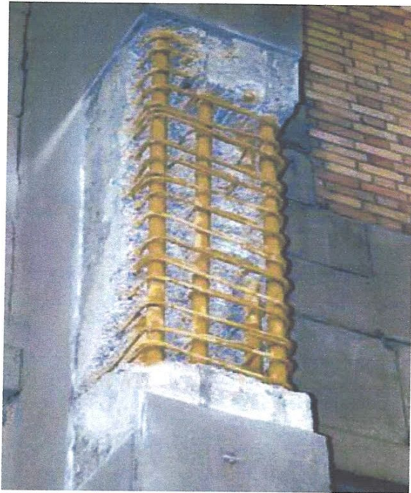
Figure IV-1 Réfection des bétons et protection des armatures.
