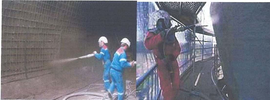
Figure IV-2 Renforcement au moyen de béton projeté
