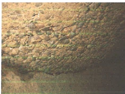
Fig 1.7 : Lixiviation du béton
