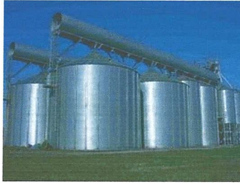
Figure 3 : Photo des silos métalliques
