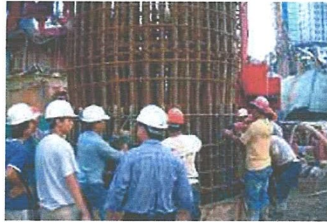
Figure 16 : Photo d'exécution d'un puits
