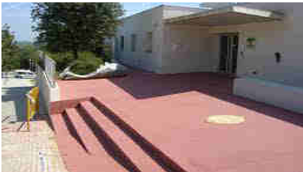
Figure 1.6b : Revêtement protecteur époxydique polymère, polyuréthane ou acrylique.
