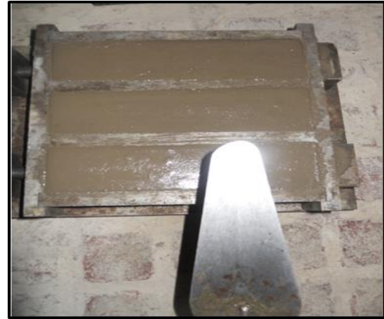
Figure 2.11: Arasage de la surface du mortier à la truelle.
