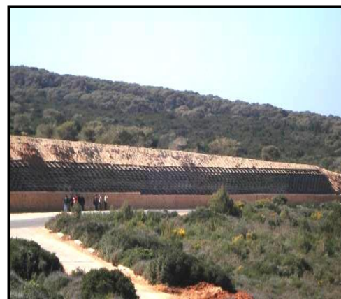
Figure 1.12: Ouvrage de Mostaganem RN11 (Algérie) - Stabilité d'un talus.
