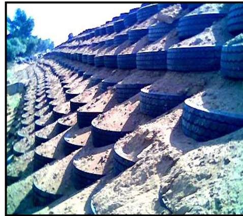
Figure 1.11: Pose de nappe de pneus Projet pilote –Route de Bousmail.
