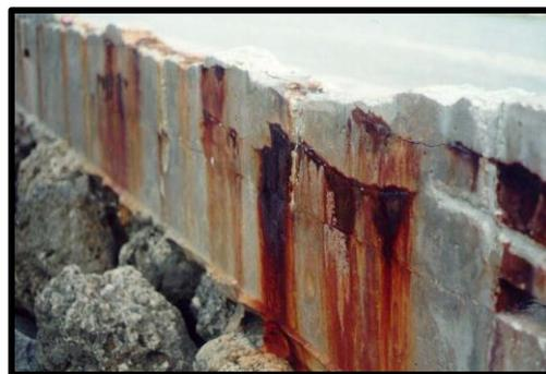
**Figure I. 34.** Corrosion des armatures [15.16]
