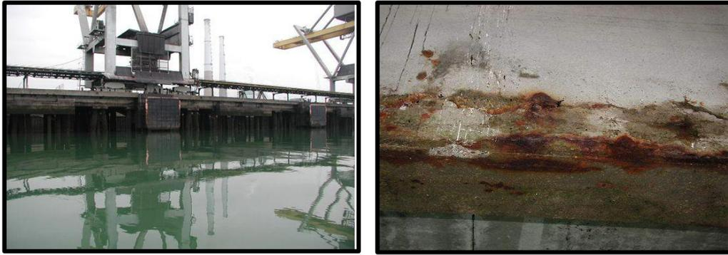
*Figure I. 35. Poutre située en bord de mer sous de l'agression des chlorures*
