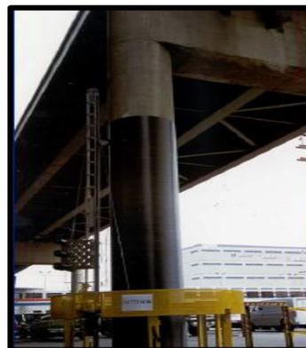
*Figure I. 56. Enveloppement de carbone*
