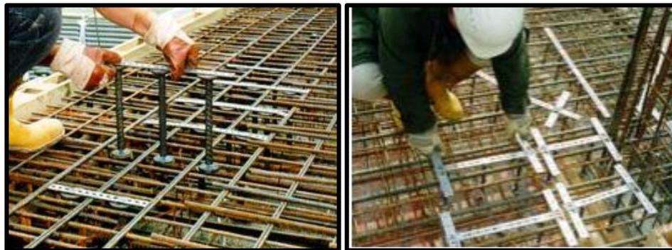
**Figure II. 44.** Placement des armatures anti poinçonnement autour d'un poteau de rive et autour d'un poteau central [75]
