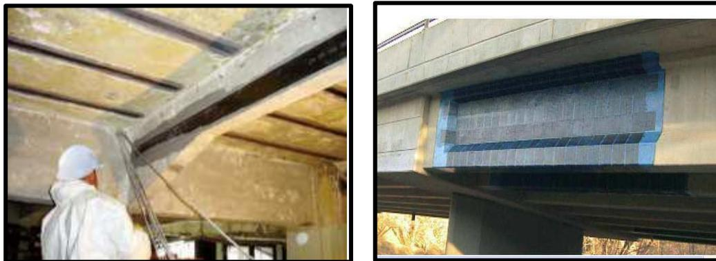
**Figure I. 58.** Mise en œuvre de bandes de renfort en sous face d'une dalle et sur des poutres [63]
