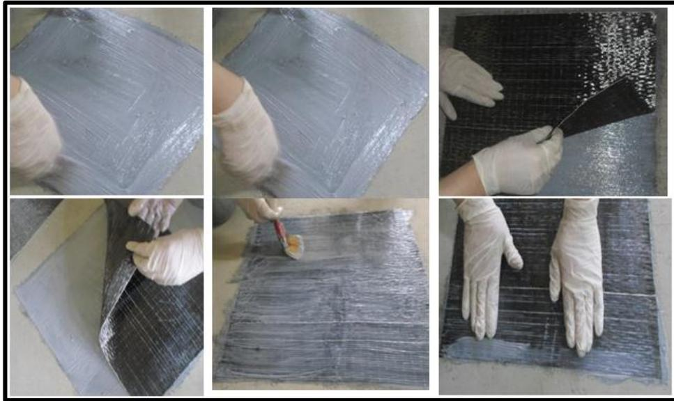
*Figure III. 20. Renforcement des dalles*
