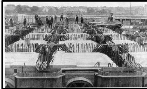
*Figure II. 42. Exemple d'utilisation des barres relevées. Moulin Roland, Brême, 1910.*
