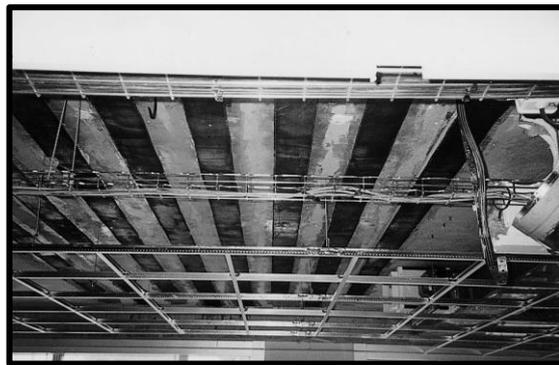
**Figure I. 60.** Renforcement d'une dalle de plancher par TFC dans un immeuble à Saint Maurice [41]
