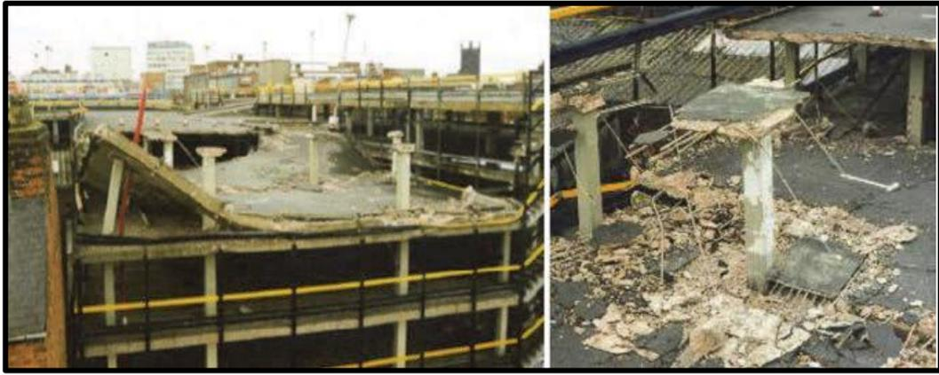
**Figure II. 35.** *Cas d'effondrement de structures par poinçonnement: parking sur plusieurs étages en phase de construction (Piper Row Car Park, Wolverhpton, 1997) [69]*
