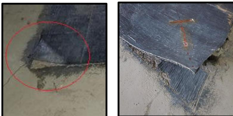
Figure IV. 97. Décollement du composite des dalles D18 et D19
