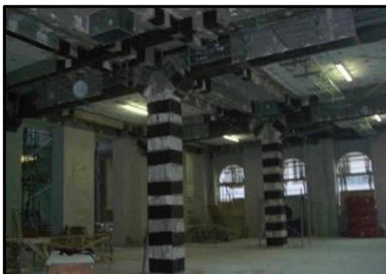
*Figure I. 46. Renforcement de structures en BA par matériaux composites [42]*
