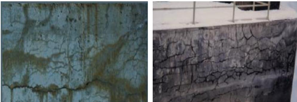
**Figure I. 36. Exemples de dégradations d'ouvrages dues à l'alcali-réaction [12]**
