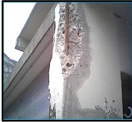
**Figure I. 32.** Dégradation des éléments d'un ouvrage par carbonatation
