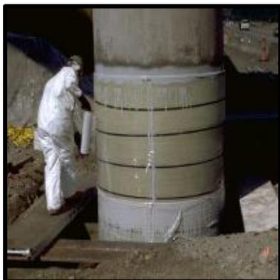
*Figure I. 55. Des tissus d'aramide pour renforcer les piles d'un pont*
