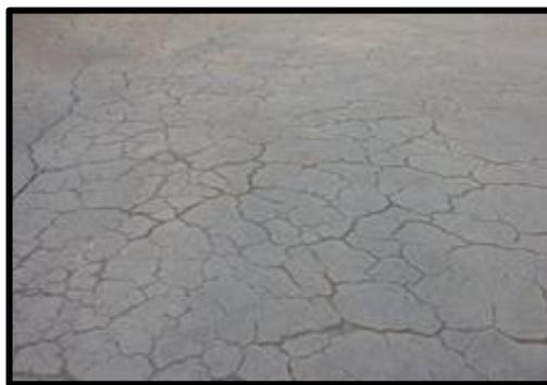
**Figure I. 37. Fissuration de peau du béton**
