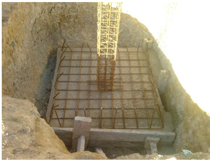
Figure 5.5 Mise en œuvre d'une semelle
