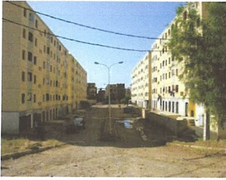
Figure II-3. Bâtiments construits environ en 1960 avec grands panneaux préfabriqués. Bonne résistance à l'action sismique.
