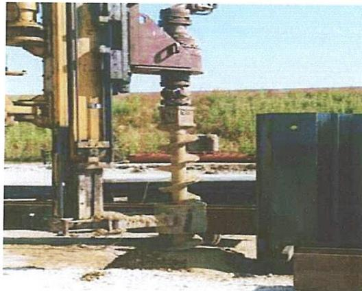
**Figure II.21** Préforage avant fonçage
