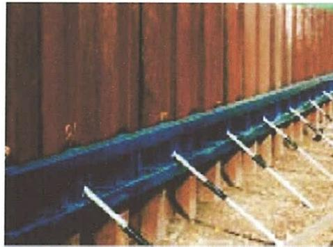
**Figure II.10** Schéma général d'un rideau de palplanches ancré en tête. Ils sont constitués de ronds d'acier filetés, ou barres d'acier à haute adhérence.
