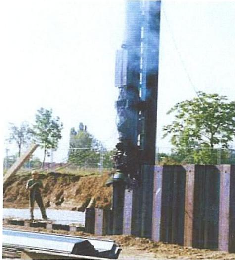
**Figure II.17** Machine de battage
