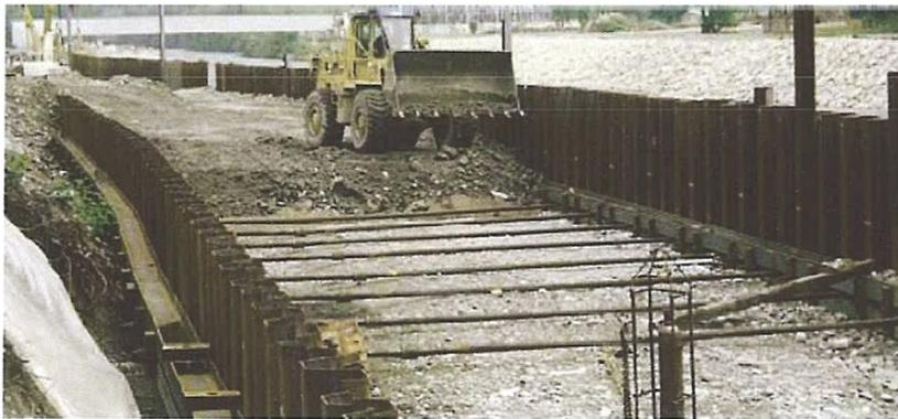
Figure II.12 Remblaiement sur un lit de tirants d'ancrage passifs
