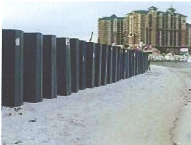
Figure II.6 La palplanche en fibre de verre.
